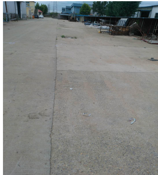
图 3-2 企业雨水管道
